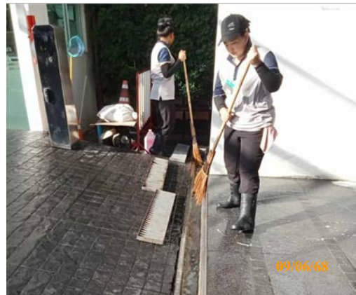
รูปที่ 2-34 การทำความสะอาดแaggerงของบ่อดักขยะ
